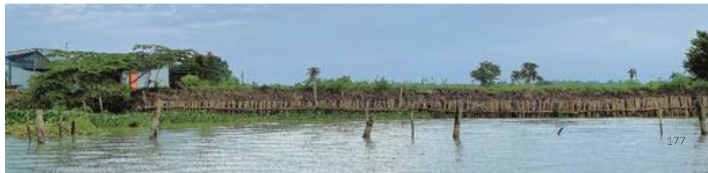
Berge du Mékong consolidée par des pieux en bois et protégée par des nappes de jacinthes d'eau Vinh Long, 2025
