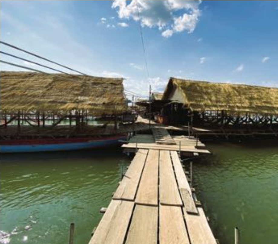
Ensemble de passerelles et de pavillons : passerelle flottante en bois reliant la rive à une île au milieu du Mékong, en passant par les pavillons. Ces derniers sont construits sur une structure en bambou, avec un plancher en bois et une toiture en chaume. Des hamacs y sont suspendus, et des marches en bois permettent d'accéder à l'eau depuis les abords des pavillons Sambour, 2025
