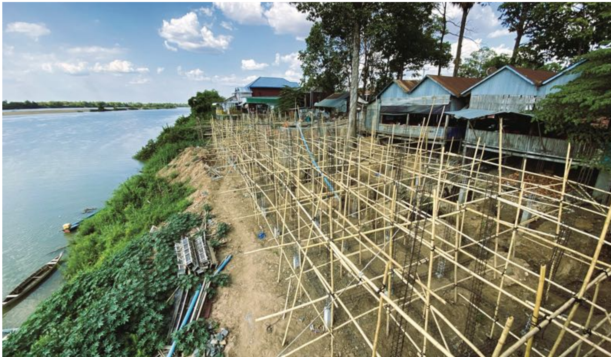
Échafaudage en bambou d'un chantier sur la berge du Mékong. Sambour, 2025
